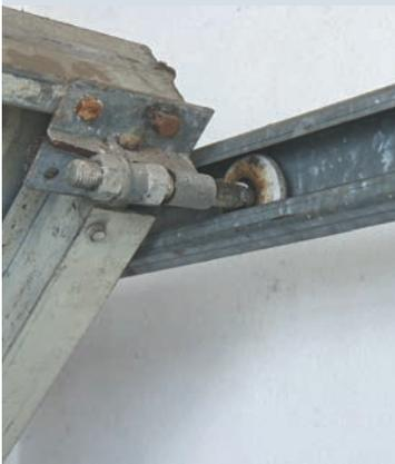
Hier besteht keine Gefahr für Personen und Fahrzeuge. Die Laufschienen sind sicher genug konstruiert, sodass die Laufrollen nicht entgleisen können und das Tor gegen Abstürzen geschützt ist.
