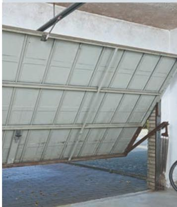
Bricht eine Feder muss die zweite das gesamte Gewicht des Tores tragen. Bei Federbruch darf kein Ungleichgewicht von mehr als 200 N entstehen.
