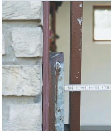
Bei einem zu geringen Sicherheitsabstand zur Zarge wie auf diesem Bild besteht erhebliche Einklemmgefahr.
